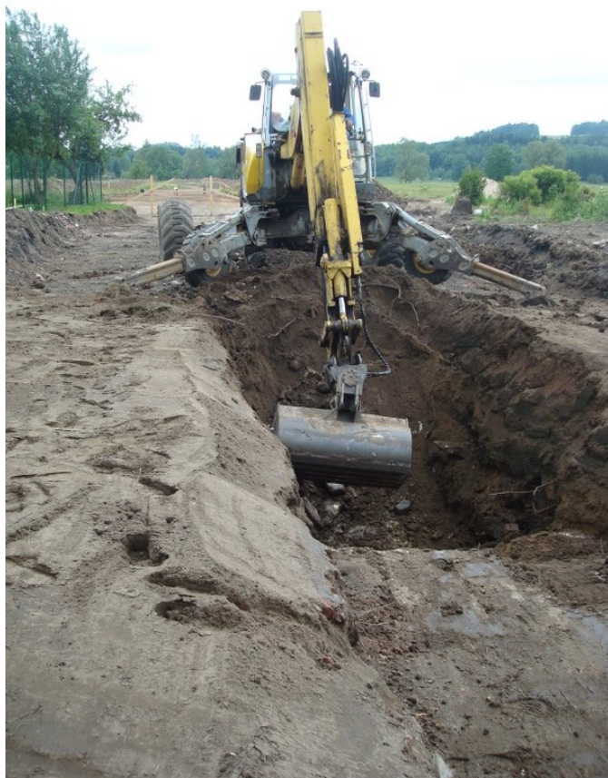
Hloubení zeminy z bývalého kanálu
